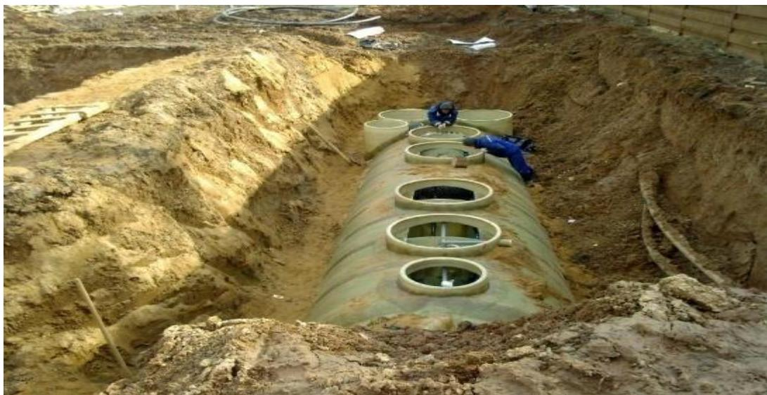
Далее сточные воды поступают во **вторичный отстойник**, где происходит разделение на биологически очищенную воду и избыточный активный ил, который перекачивается в первичный отстойник эрлифтом. Далее очищенная вода может либо дренироваться в грунт, через фильтрационное поле (песчано-щебеночный фильтр), либо после обеззараживания ультрафиолетом сбрасываться в водный объект. Когда приток стоков отсутствует, вода циркулирует по установке.
