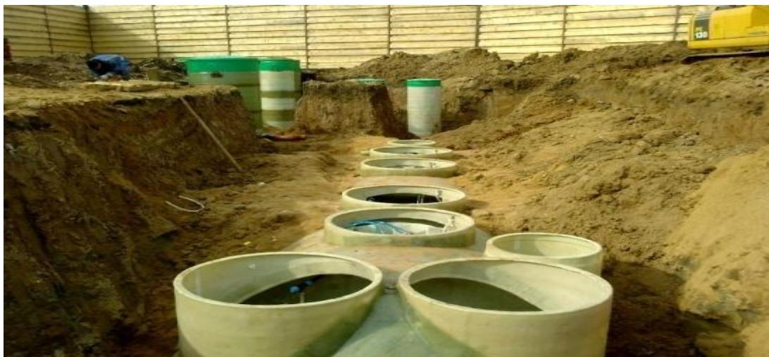
Производительность таких станций - от 3 до 30 м<sup>3</sup> стоков в сутки. В зависимости от производительности изменяются габаритные размеры и комплектация оборудования.
