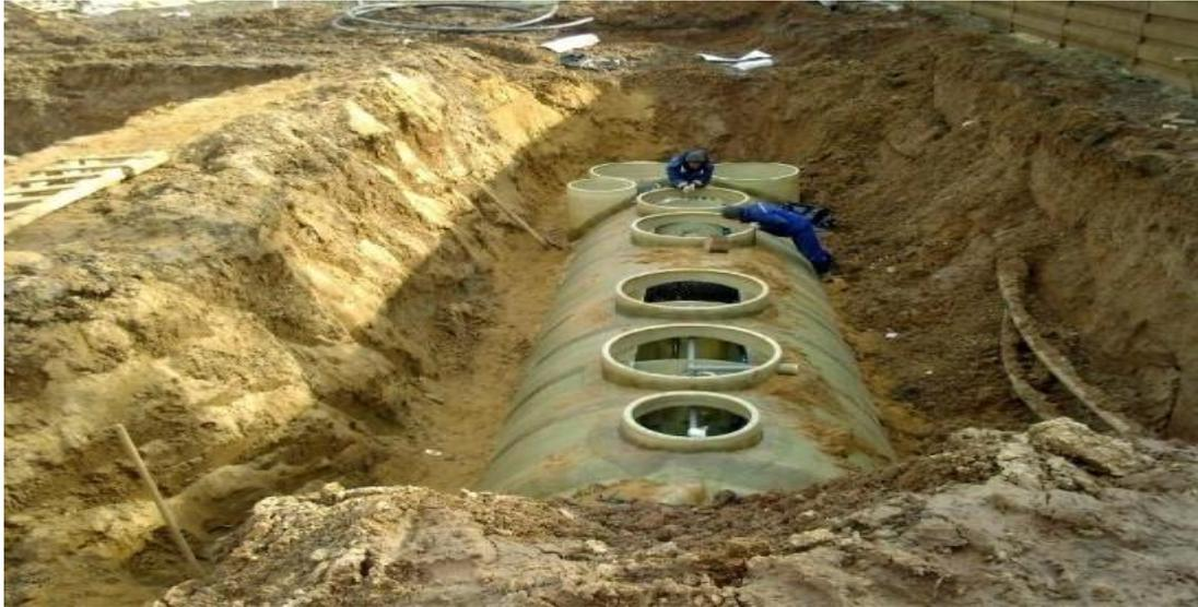
Далее сточные воды поступают во **вторичный отстойник**, где происходит разделение на биологически очищенную воду и избыточный активный ил, который перекачивается в первичный отстойник эрлифтом. Далее очищенная вода может либо дренироваться в грунт, через фильтрационное поле (песчано-щебеночный фильтр), либо после обеззараживания ультрафиолетом сбрасываться в водный объект. Когда приток стоков отсутствует, вода циркулирует по установке.
